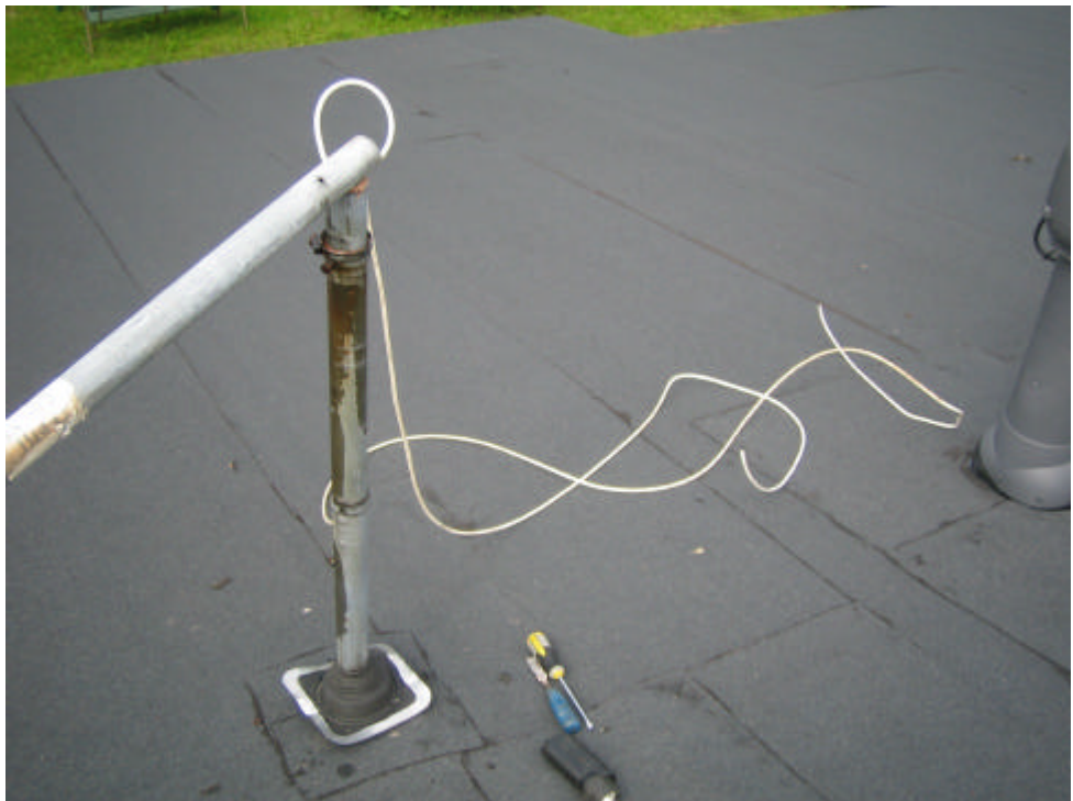
KUVIO 22. Ylimääräisten antennin syöttöjohtojen poistaminen
