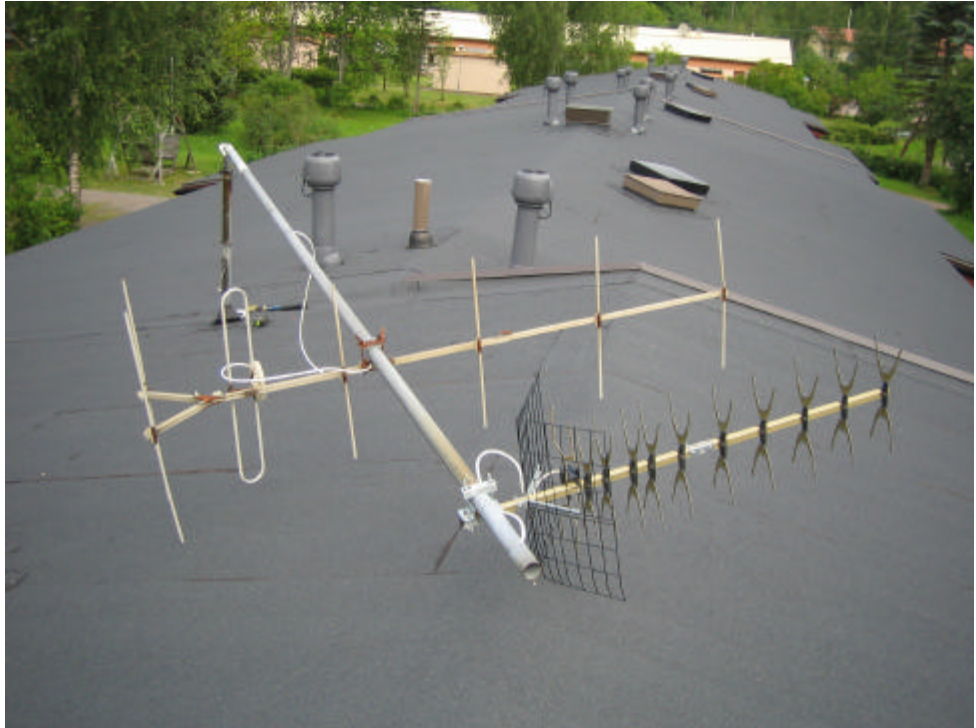
KUVIO 21. Antennimaston kaataminen ja vanhojen antennien poistaminen
