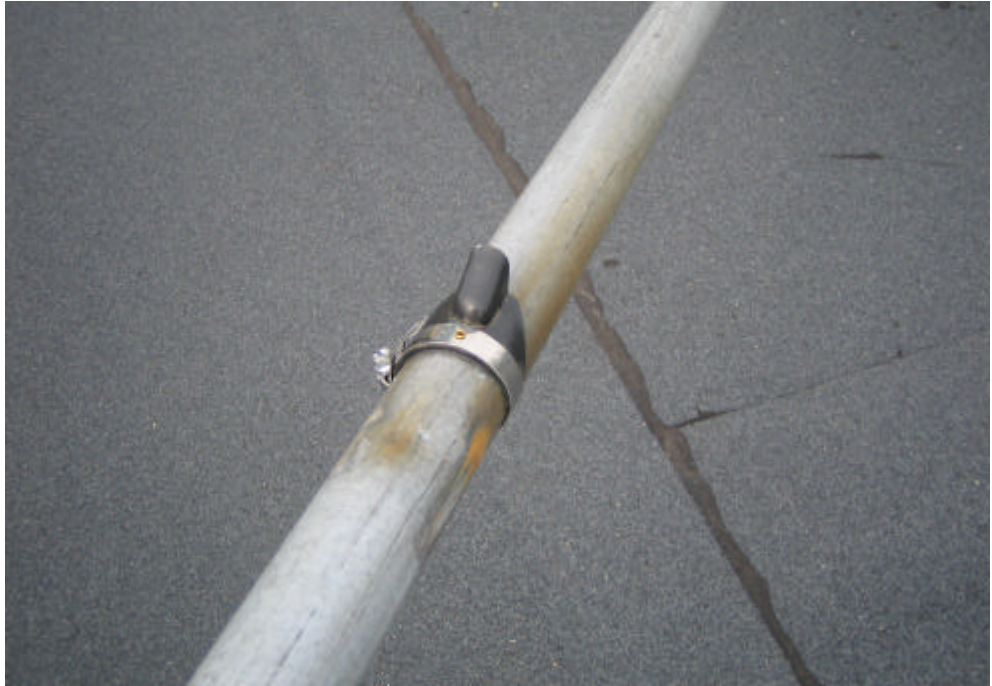
KUVIO 24. Ylimääräisten antennijohtojen läpivientien tiivistäminen antenniputkesta
