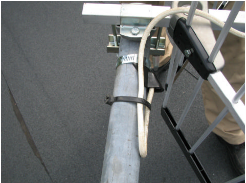
KUVIO 30. Johdon kiinnittäminen mastoon
