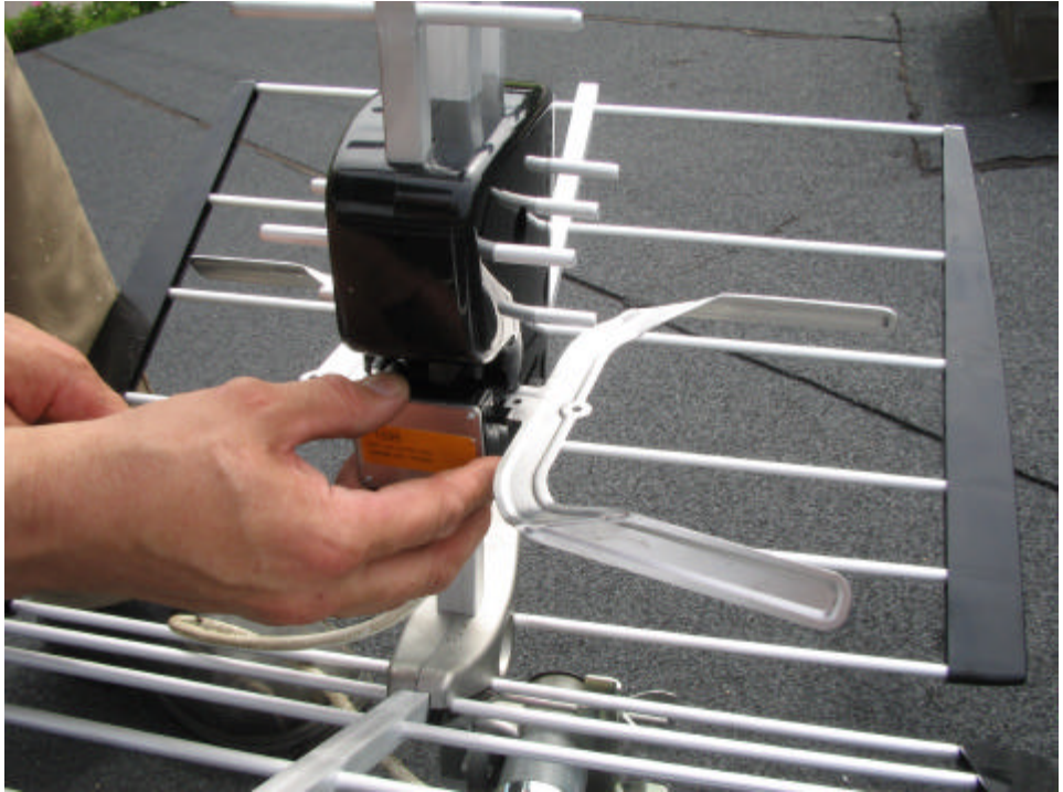
KUVIO 29. Dipolin kiinnittäminen antenniin
