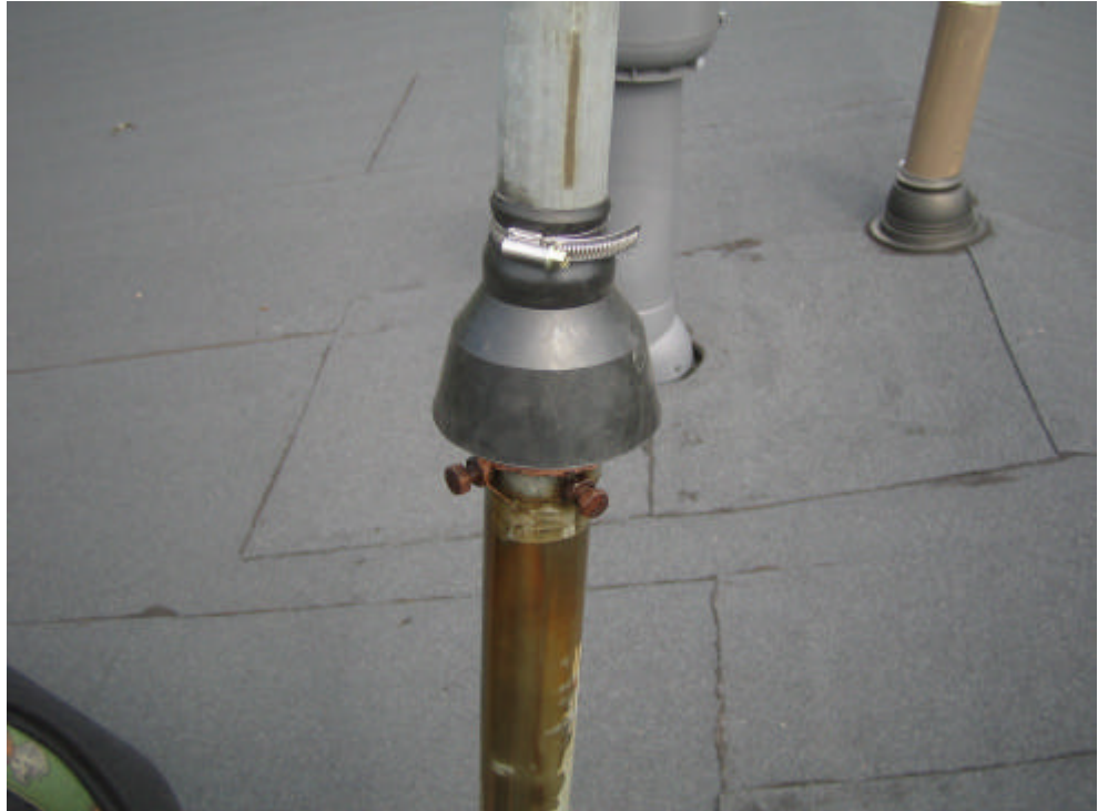
KUVIO 33. Maston pystyttämisen jälkeen vielä vesisuojan kirityspanta kiristettiin
