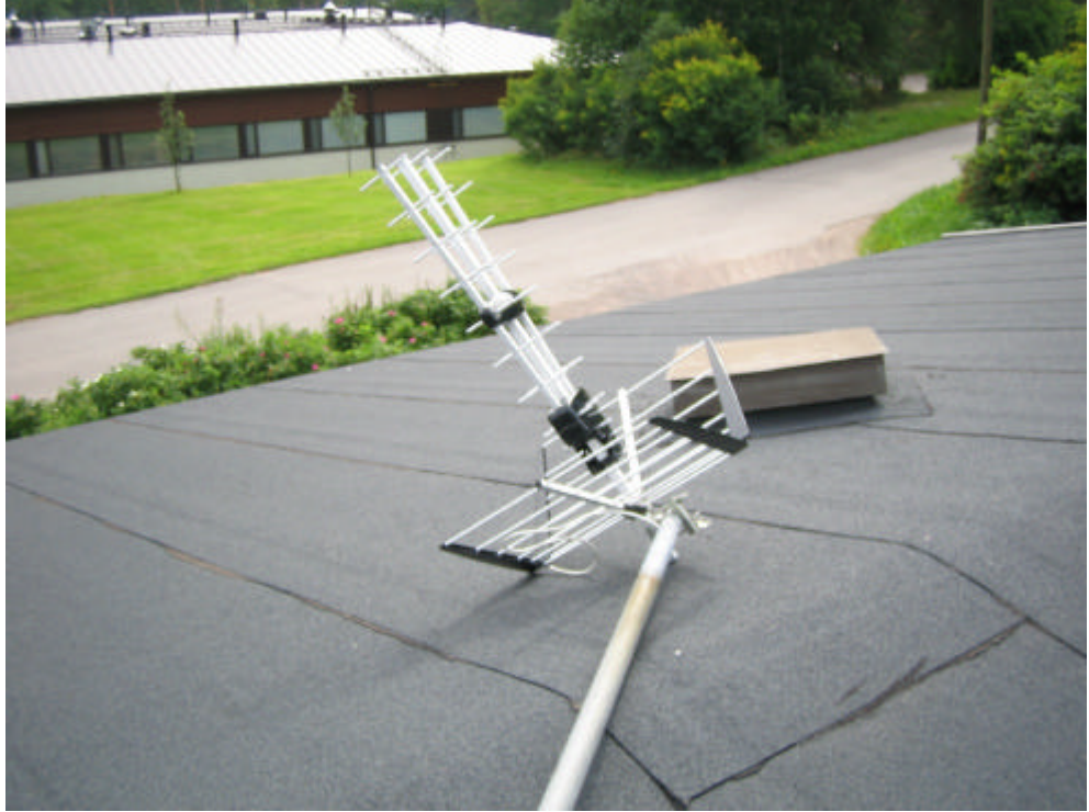
KUVIO 26. Uuden antennin kiinnitys mastoputkeen
