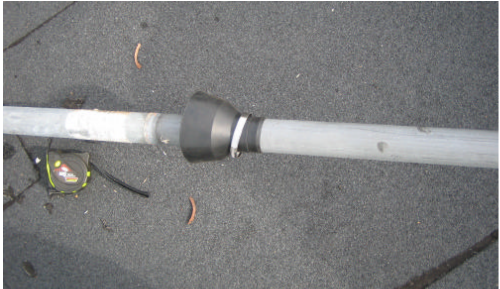
KUVIO 23. Mastoputken kumisen vesisuojan uusiminen
